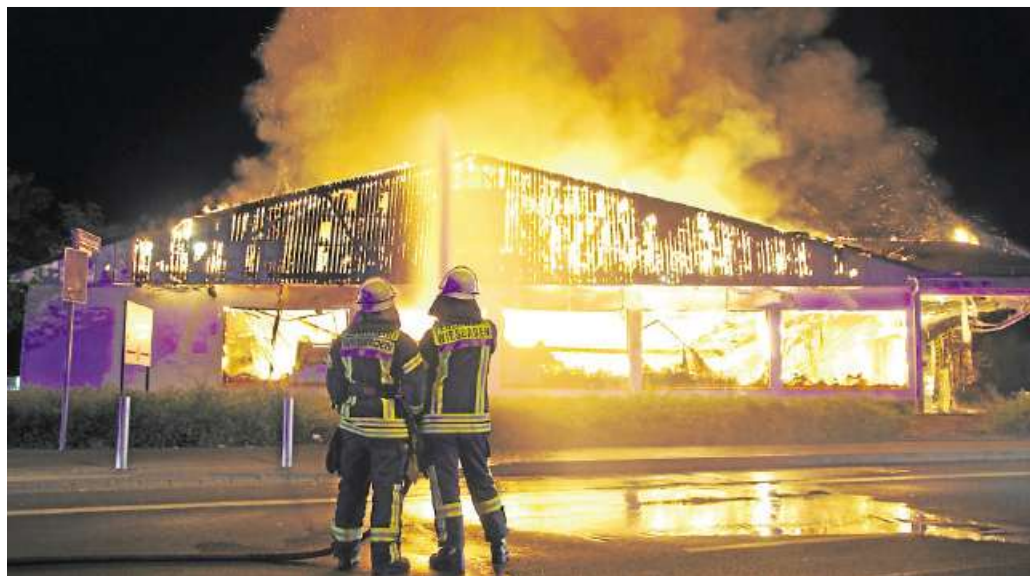
Lichterloh in Flammen ging der Netto-Markt in Kastel am Ostermontag vergangenen Jahres auf. Innerhalb von Minuten brannte das Gebäude aus. Archivfoto: Michael Ehresmann
